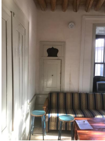
Foto.11- Arapgir Kaşkal Konağı Ahşap Yüklük,Dolap ve Kandillik.
