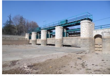
Çarşamba Çayı Mansap Cephesi
