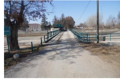
Çarşamba Çayı Köprü Döşemesi
