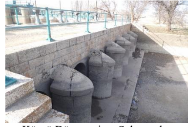
Köprü Döşemesi ve Selyaranlar
