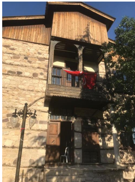
Foto.3- Arapgir Kaşkal Konağı Batı Cepheden.
