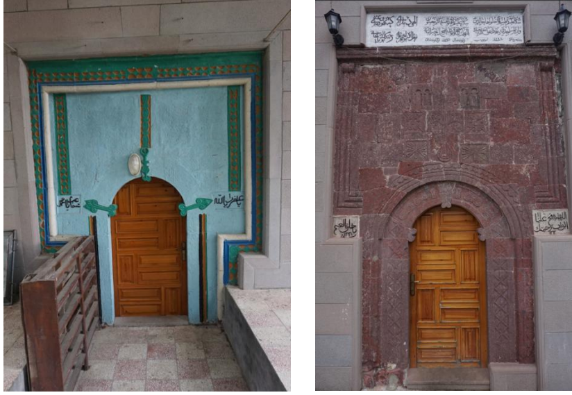
Görsel 6-7. Ortaköy Camii kuzey ve batı cephede bulunan giriş kapıları
