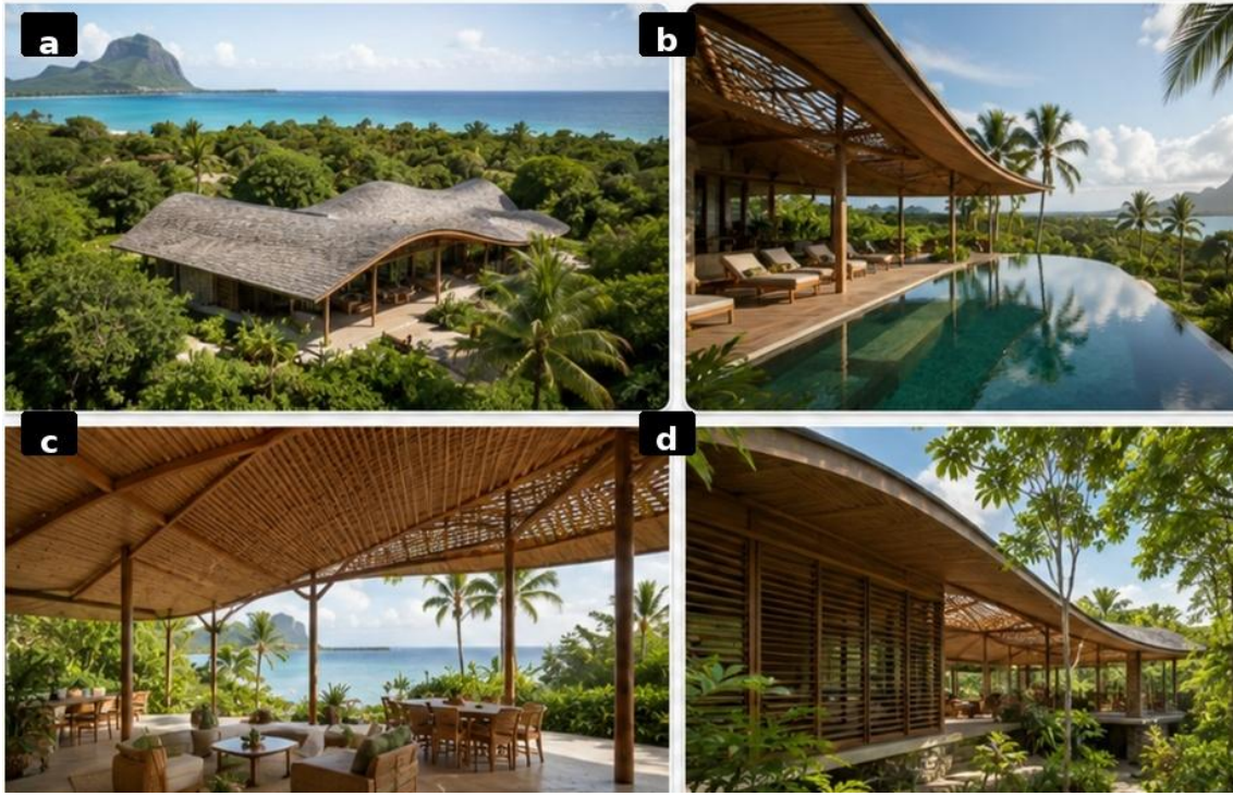
Görsel 3. Ekolojik Villa örneğinde ekolojik tasarım yaklaşımı: (a) yapının doğal çevre ve yerel peyzajla ilişkisi, (b) gölgeleme sağlayan geniş saçaklar ve açık yaşam alanları, (c) doğal havalandırmayı destekleyen geçirgen mekân kurgusu, (d) yerel malzeme ve iklimsel uyuma dayalı cephe düzeni.
