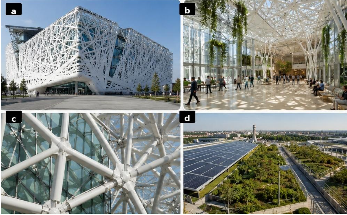
Görsel 6. Palazzo Italia örneğinde rejeneratif tasarım yaklaşımı: (a) dallanan cephe kurgusu ve yapı kabuğu, (b) iç mekânda ışık, geçirgenlik ve bitkilendirme ilişkisi, (c) doğadan esinlenen taşıyıcı/cephe sistemi ayrıntısı, (d) çatı düzleminde enerji üretimi ve yeşil alan kullanımı.
