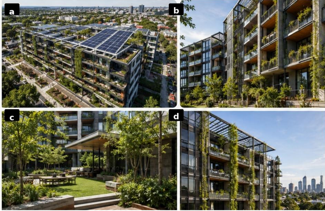
Görsel 4. K2 Apartmanları örneğinde yeşil tasarım yaklaşımı: (a) güneş panelleri ve çatı düzleminde enerji üretimi, (b) cephede gölgeleme ve bitkilendirme kullanımı, (c) ortak açık alan ve peyzajla ilişki, (d) yeşil cephe, doğal havalandırma ve kent manzarası ilişkisi.
